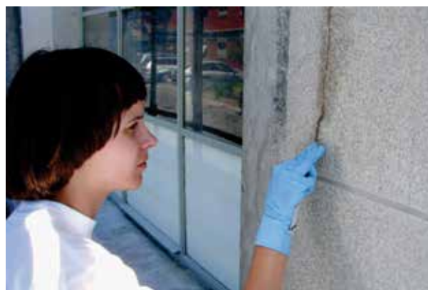
Figura 22 – Colmatação de fendas.
